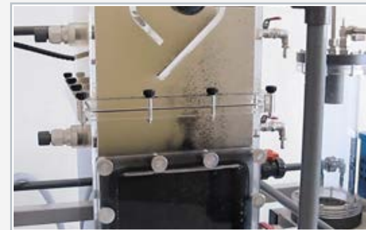
Reactor UASB en el modo de pruebas
