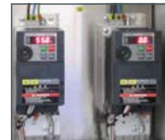
Convertidores de frecuencia para controlar las bombas
