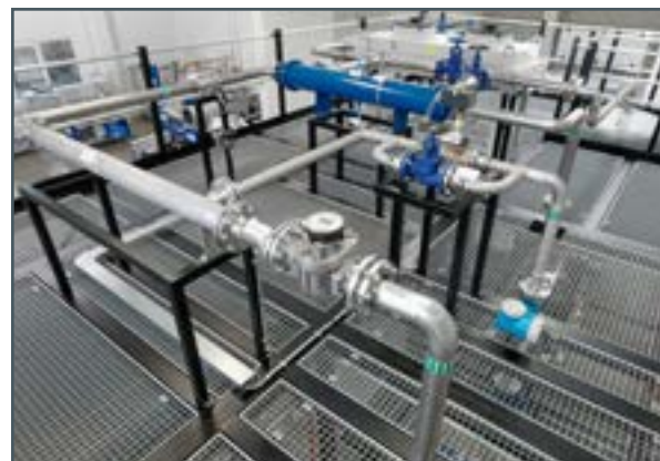
Reactor térmico con sistema de inyección química
