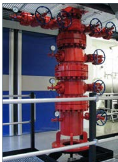
Boca de pozo
